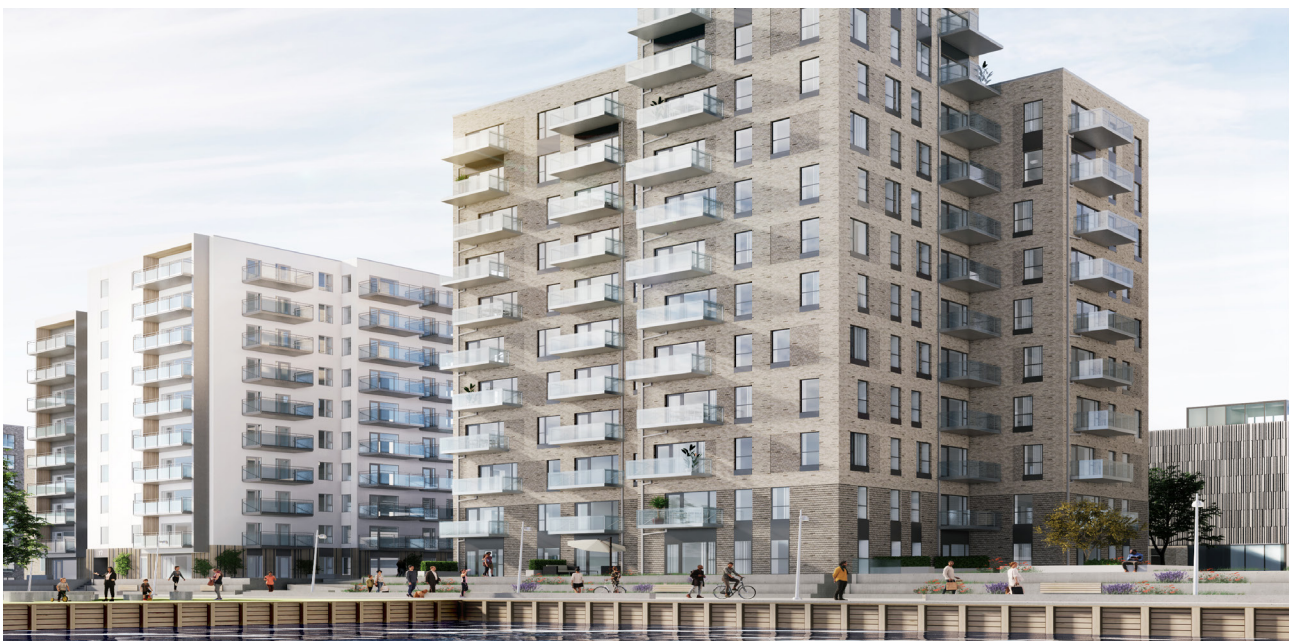
Beddingen, Østre Havn, Aalborg 5.675 m 2 udlejningsboliger solgt til private investorer til aflevering i efteråret 2021.
