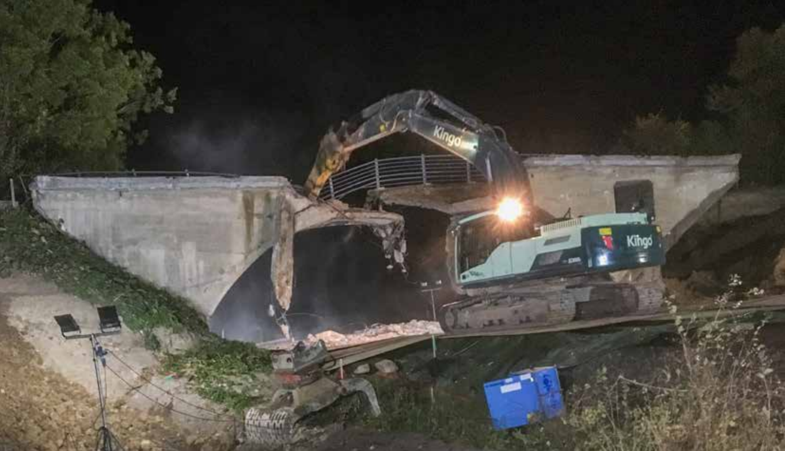
Nedrivning af én ud af 22 banebroer på strækningen fra Ringsted til Femern.
