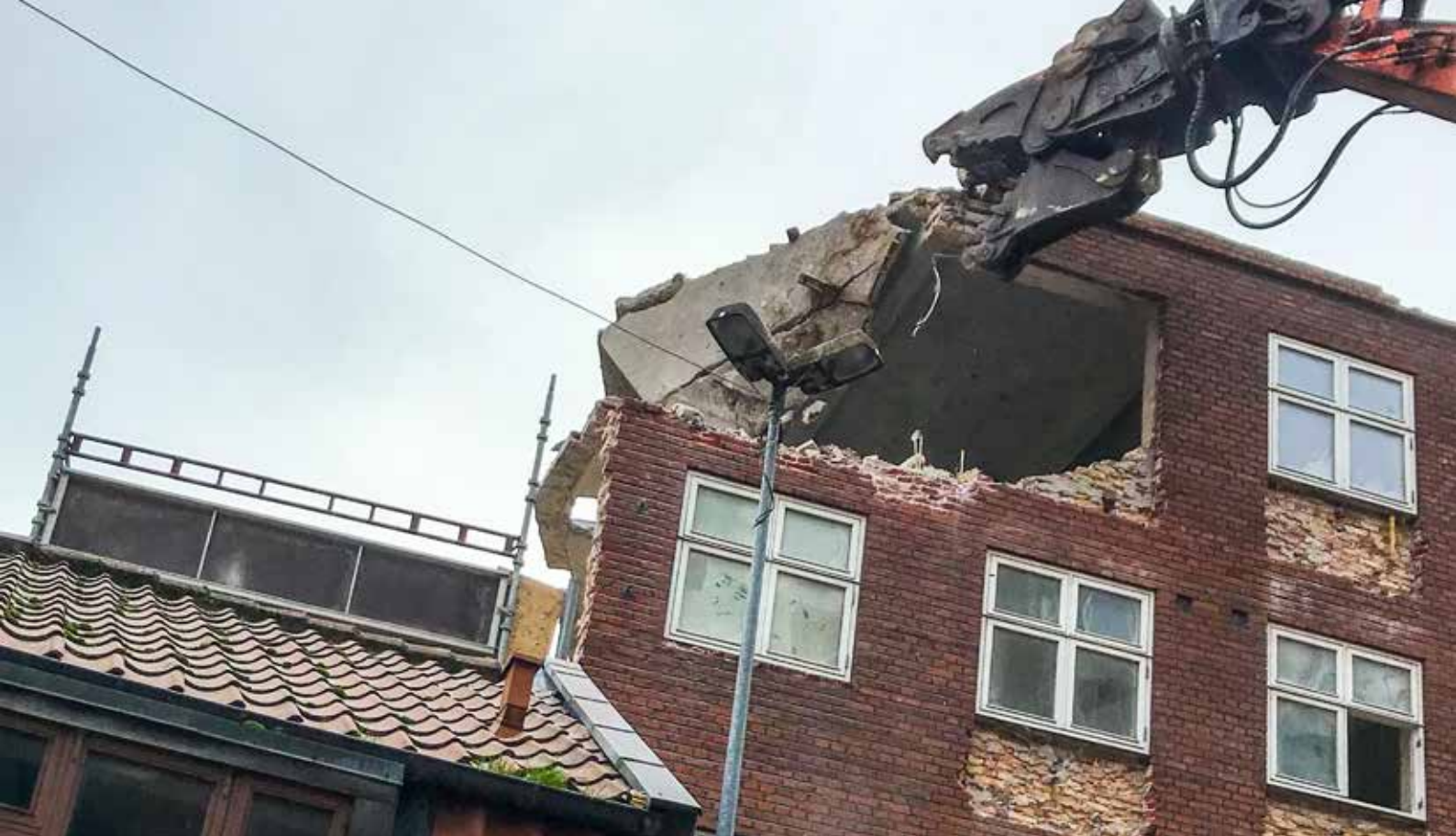
Biblioteksparken i Aarhus – en stor og meget kompleks nedbrydnings- og miljøsaneringsopgave. Her er nedrivningen af en stor ejendom i Vestergade i gang.
