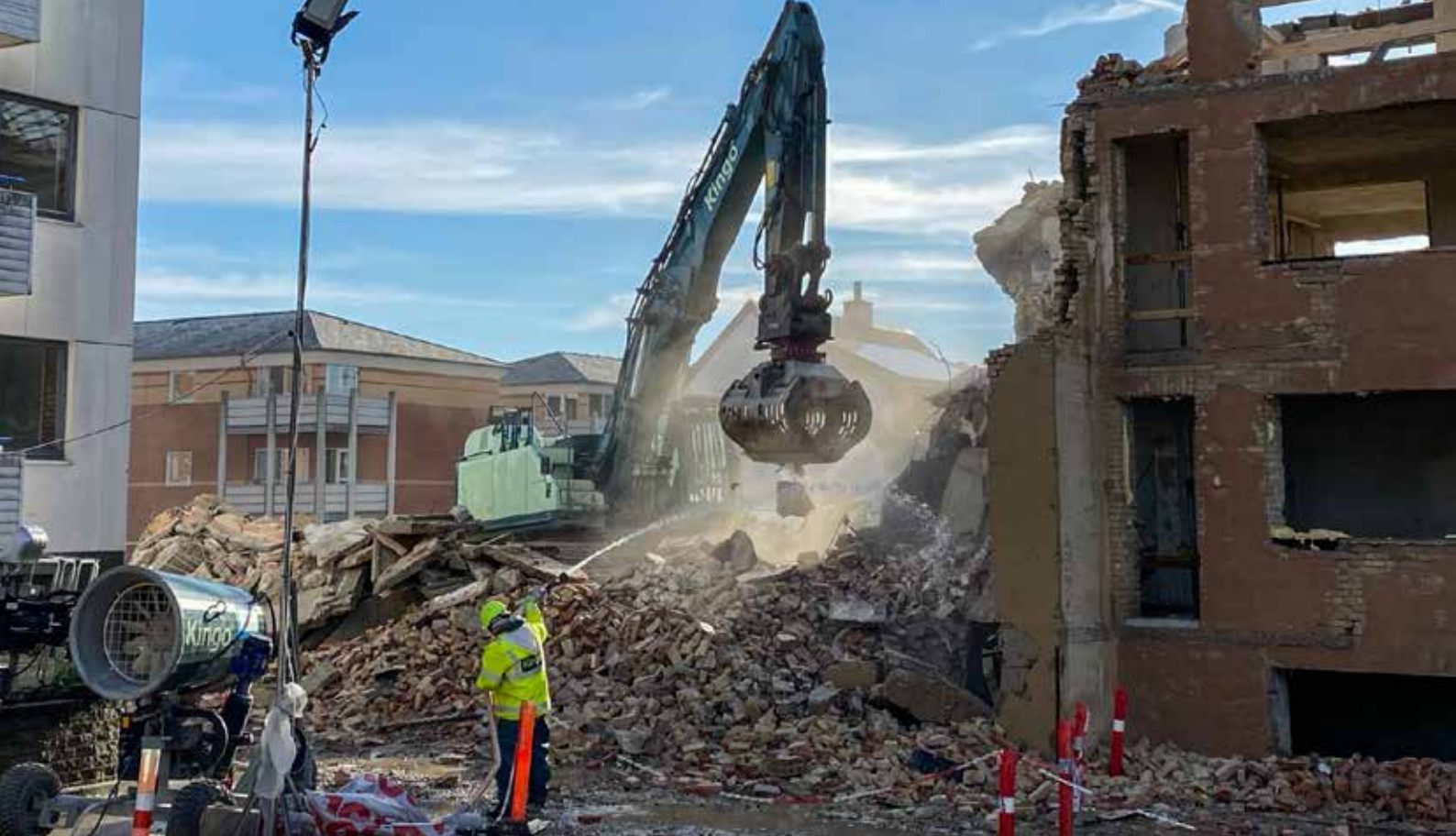
Totalnedrivning af Vinkelgården i Frederikshavn.
