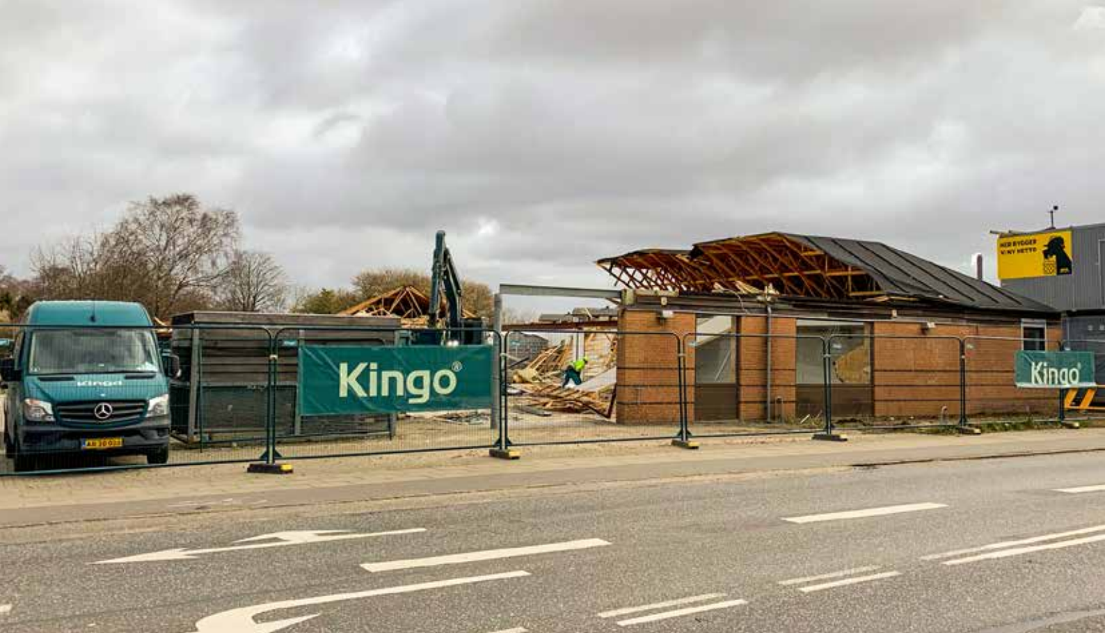
Totalnedrivning af Aldi forretning på Nørrevænget i Silkeborg.
