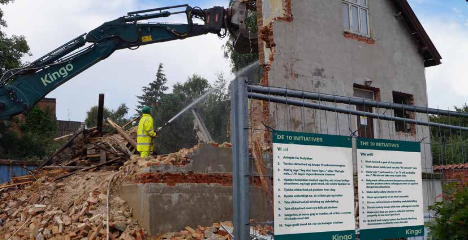
Plancher med "10 initiativer" til at forebygge arbejdsulykker ophænges i skurvogne og rundt omkring på Kingos byggepladser på flere sprog.
