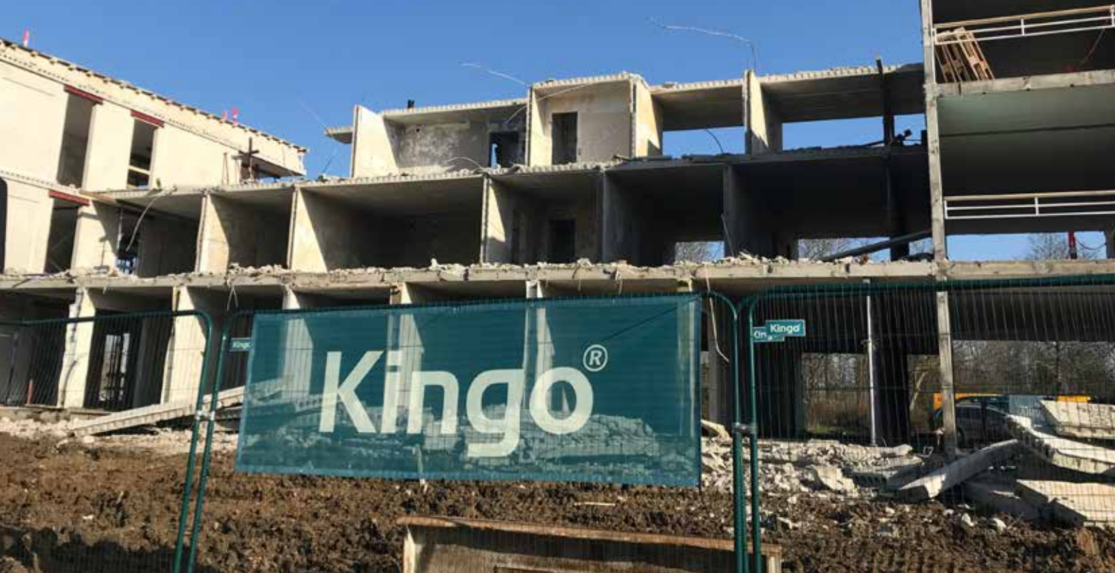
Råhus gjort klar til genbrug og nyindretning i Trigeparken i Aarhus.
