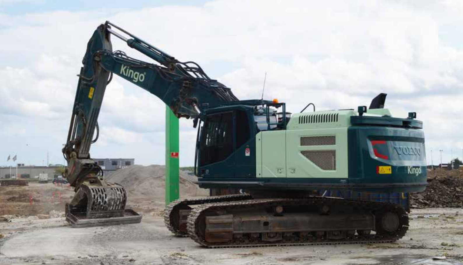
Totalnedbrydning af 35.000 m 2 lagerhaller og garager hos Gasa i Tilst.
