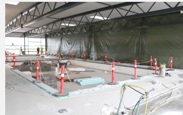
DGI Huset Vordingborg
