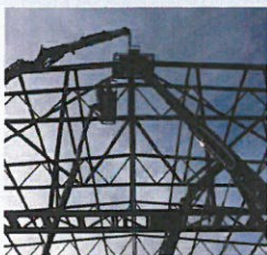
Sikkerhed i detaljen DATACENTRE
