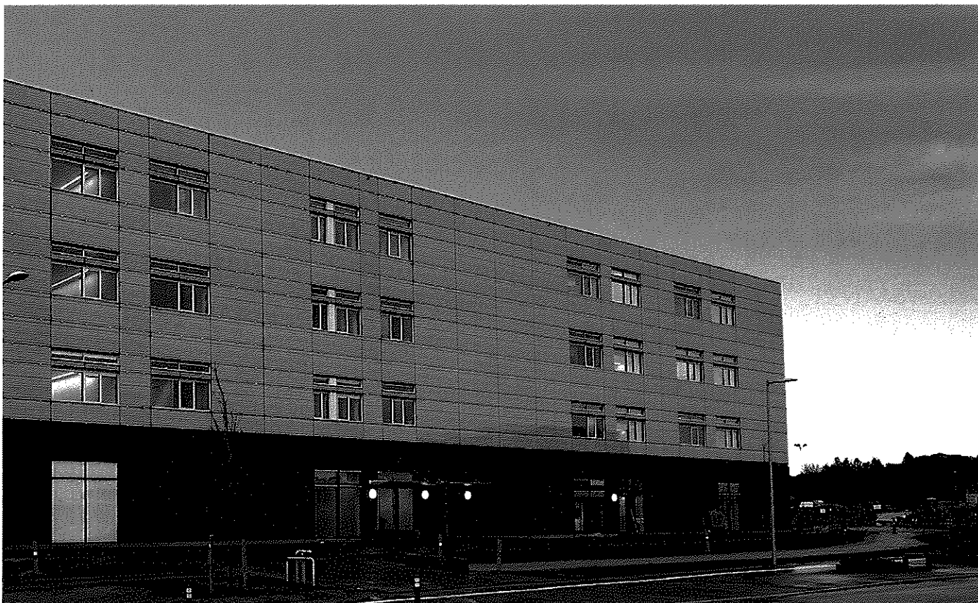
PensionDanmark er medinvestor i det nyopførte OPP-hospital i Slagelse
