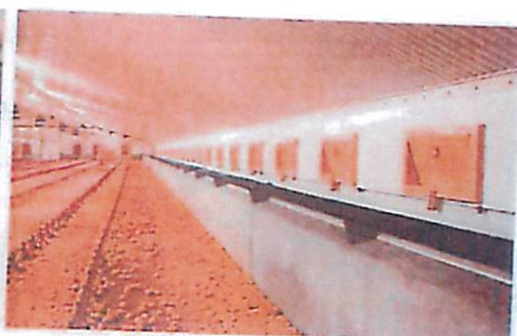
TPI's vægventiler i en kyllingestald
