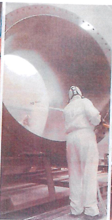
Påføring af korrosionsbeskyttende Accoshield belægning
