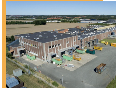
Miljøsanering og nedrivning af fabriksbygning Randers
