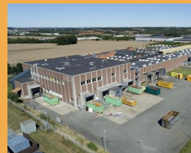
Miljøsanering og nedrivning af fabriksbygning Randers
