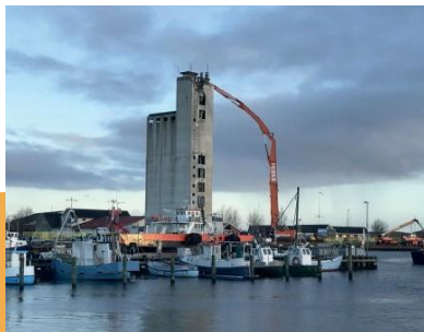
Nedbrydning af silo Kerteminde Havn
