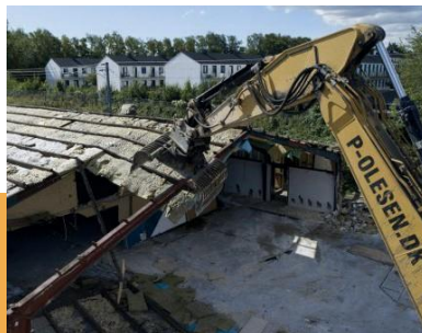
Nedrivning af industriområde Risikov
