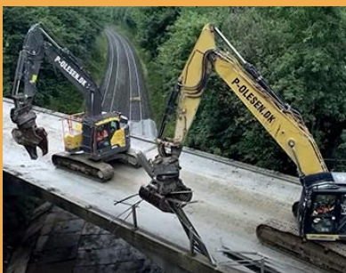
Nedrivning af bro Horsens
