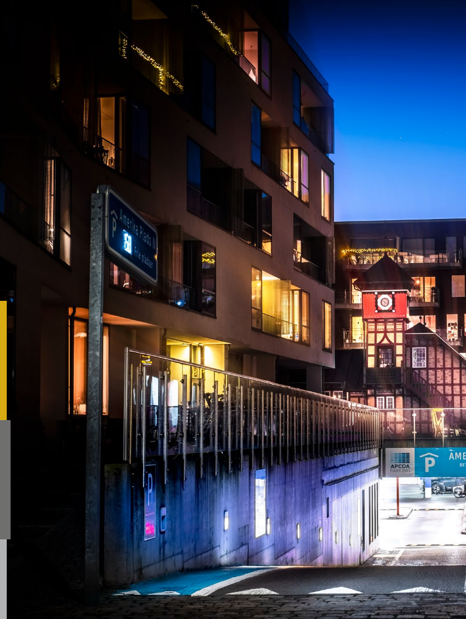
Parkeringsanlægget Dampfærgevej/Amerika Plads, København Ø
