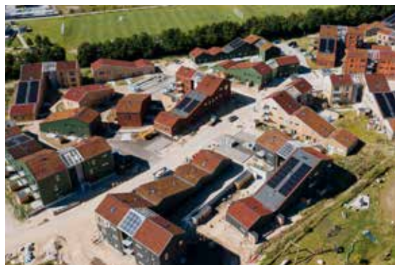
Lisbjerg er et udviklingsprojekt med 215 familieboliger i henholdsvis rækkehus og etagebyggeri på i alt 18.933 m 2 . Byggeriet blev opført som 12 hus-klynger og DGNB Guld certificeret.
