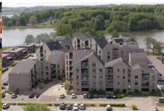
Ovenvande omfatter 128 boliger på i alt 13.540 m 2 og er opført med bærende konstruktioner i betonelementer og med listepaptag. Projektet er opdelt i 2 etaper og opført for 2 forskellige bygherrer.
