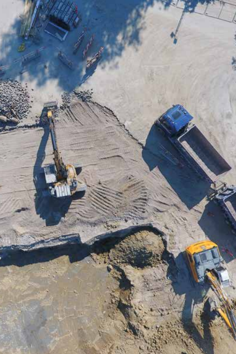
Igangværende arbejde på AKF's byggeplads i Kirkebjerg Søpark i Brøndbyvester.
